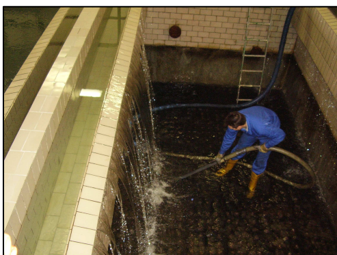
Obr. 1. Odvoz GAU z filtrů: 28.3.2007
