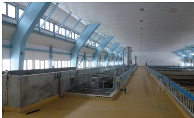
Budova ÚV Bedřichov s reaktory přípravy suspenze a flotací vlevo a filtrací přes materiál Filtralite Mono-Multi vpravo
