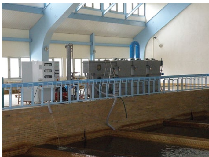
Poloprovozní model flotace při předprojektové přípravě rekonstrukce filtrace na ÚV Bedřichov
