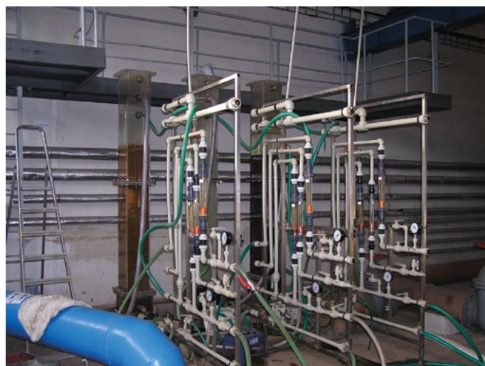
Poloprovozní filtry při předprojektové přípravě rekonstrukce filtrace na ÚV Bedřichov
